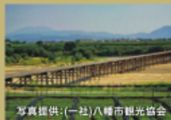
②上津屋流れ橋
